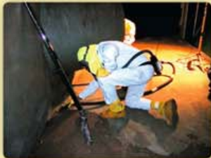
Peale jäätmete eemaldamist puhastatakse ala veel lahtisest saastest (näiteks tolmumejaga).
