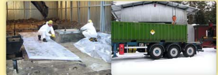
Sügis 2008. Ettevalmistustööd kõrgaktiivsete jäätmete eemaldamiseks.
