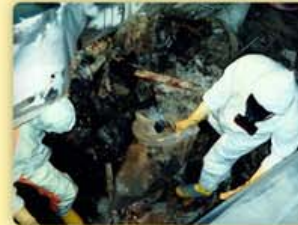
Nii võetakse välja ja kogutakse kokku tahkeid madalaktiivseid radioaktiivseid jäätmeid.
