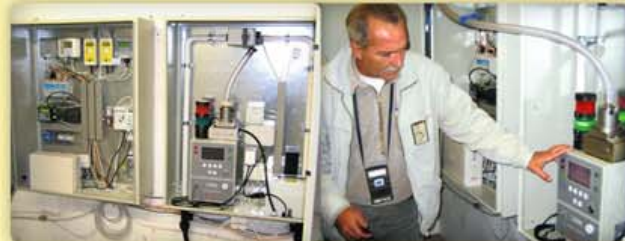
Kiirgusseire süsteem allesjäänud reaktoriseksioonides.
