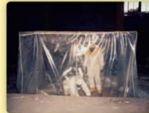
Radioaktiivse saaste leviku vältimiseks püstitatud kilest katteehitis.
